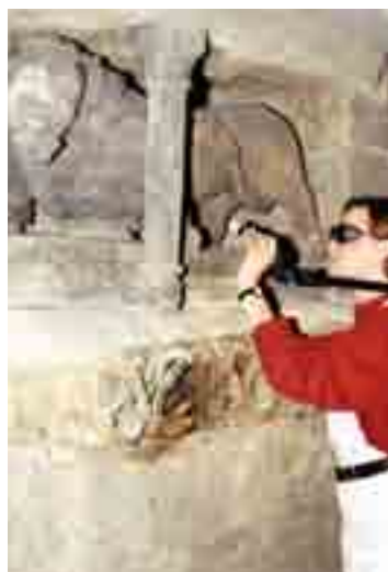
Links: Steinretusche am Tympanon des Riesentores Rechts: Am Riesentor wurde zum ersten Mal die Laserreinigung angewendet
