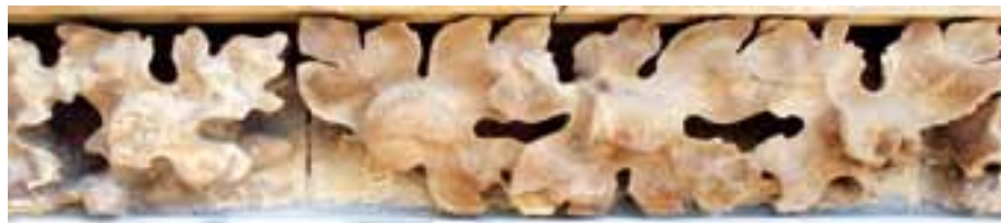
Oben: Westfassade – ein aufwändig restauriertes, fein ausgearbeitetes Blattwerk im Gesimsfries Unten: Das Ausfüllen der offenen Fugen im Mauerwerk
