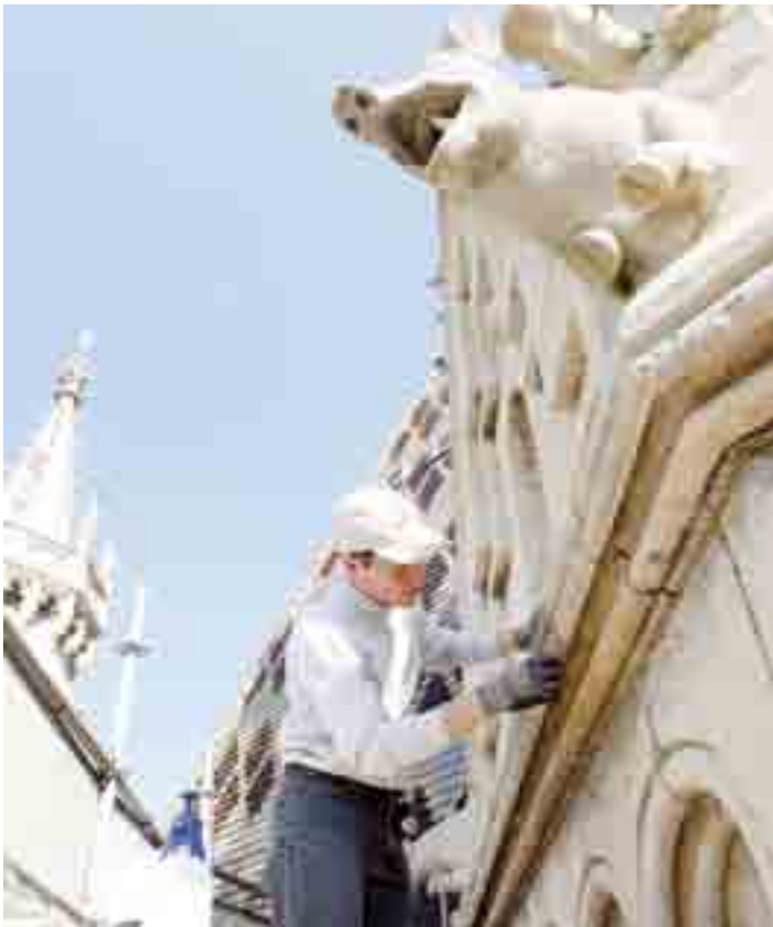
2011: Südlicher Heidenturm – Glättung der Gesimsoberfläche
