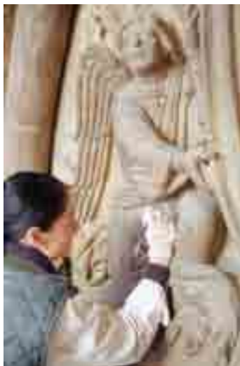
Links: Steinretusche am Tympanon des Riesentores Rechts: Am Riesentor wurde zum ersten Mal die Laserreinigung angewendet
