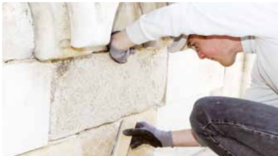
Oben: Westfassade – ein aufwändig restauriertes, fein ausgearbeitetes Blattwerk im Gesimsfries Unten: Das Ausfüllen der offenen Fugen im Mauerwerk
