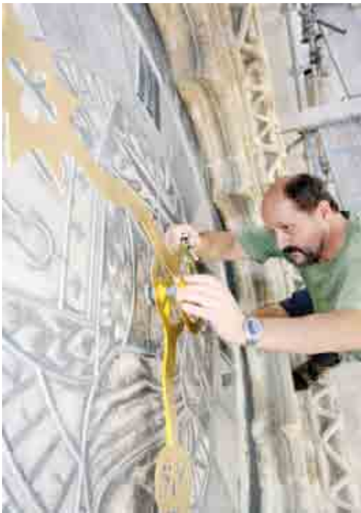
Die Justierung der vergoldeten Zeiger an der nördlichen Uhr
