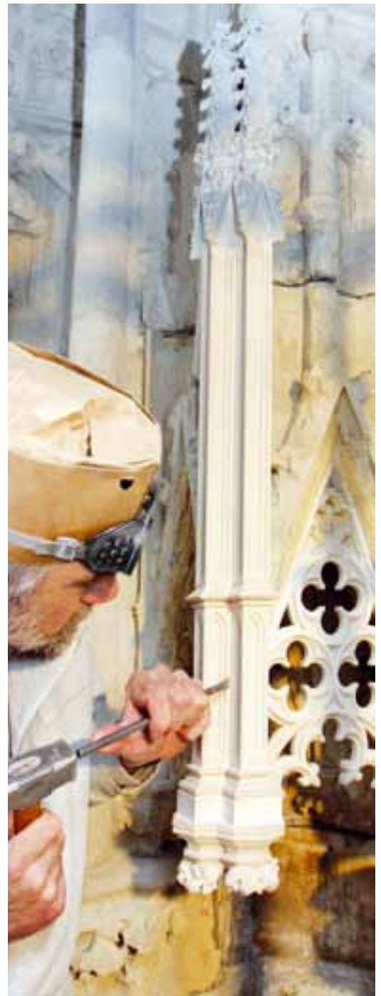
Eine aus Sandstein angefertigte Ergänzung an einem Baldachin an der Westfassade
