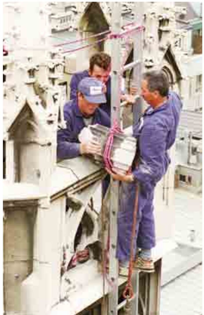
1994: Nördlicher Heidenturm – Bergung einer absturzgefährdeten, ca. 60 kg schweren Konsole
