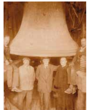
Die „Halbpummerin“ nach Fertigstellung des elektrischen Antriebs – 1925
