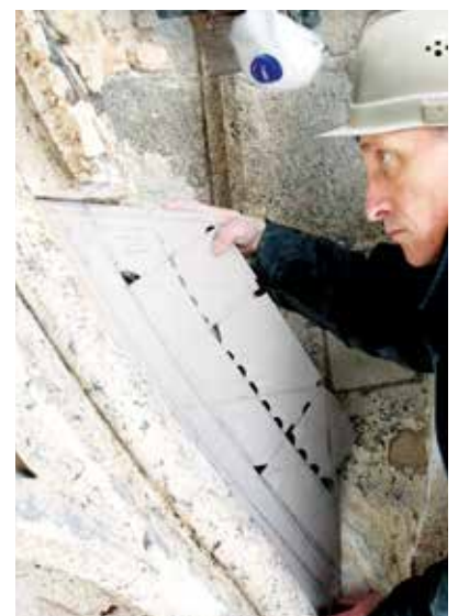
Anfertigung einer Schablone für ein neues Stück
