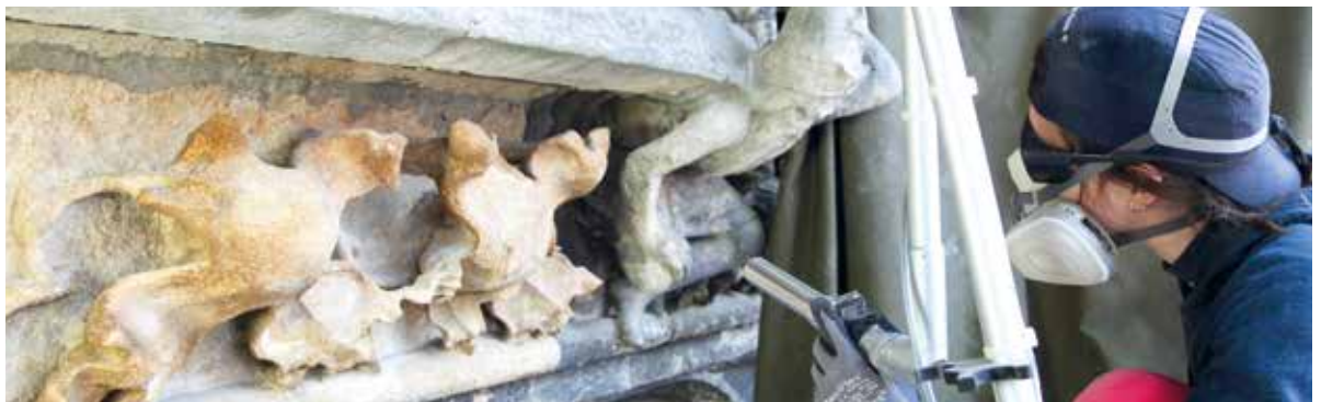
Laserreinigung des Laubwerkfrieses an der Südfassade
