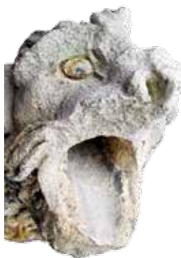
Wasserspeier durch Umwelteinflüsse beschädigt
