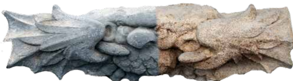
Steinerner Drache am Südturm während der Reinigung von der Sinterkruste
