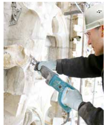
Herausschneiden eines nicht mehr belastbaren Steines aus dem Mauerwerk
