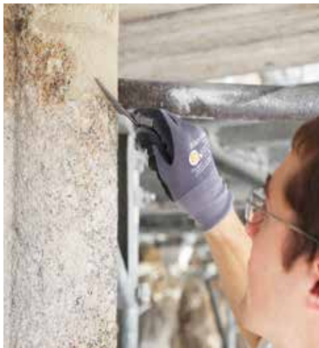
Verschließen einer Fuge
