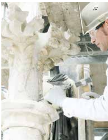
Steinmetzarbeiten bei der Restaurierung einer Kreuzrosette
