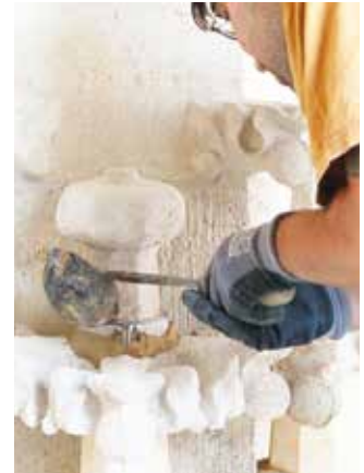
Schmelzen (oben) und Eingießen (unten) von Blei
