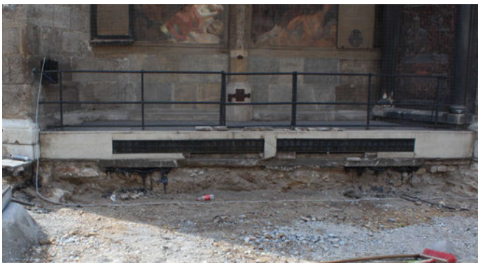
Pflasterarbeiten am Chor. Nur die oberste Schicht wurde abgetragen
