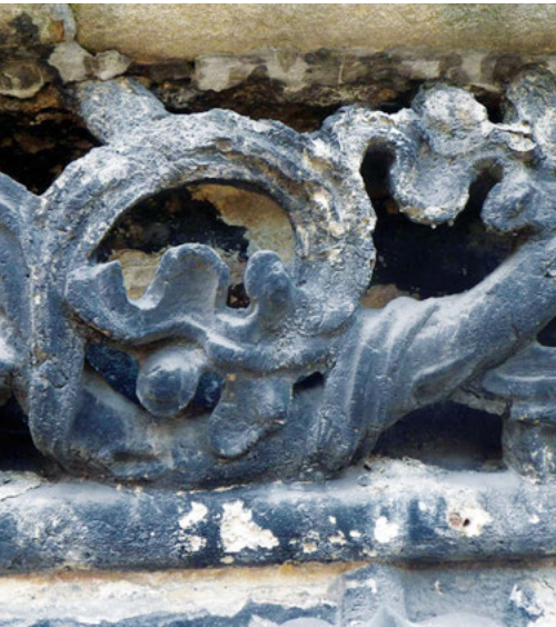
Blattfries am Nordturm mit schwarzer Kruste und neues Stück, das ergänzt wurde
