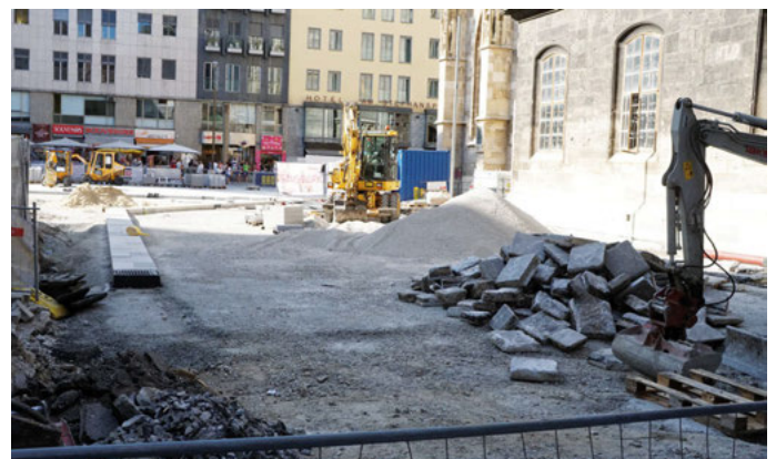
Pflasterarbeiten an der Südseite des Stephansplatzes
