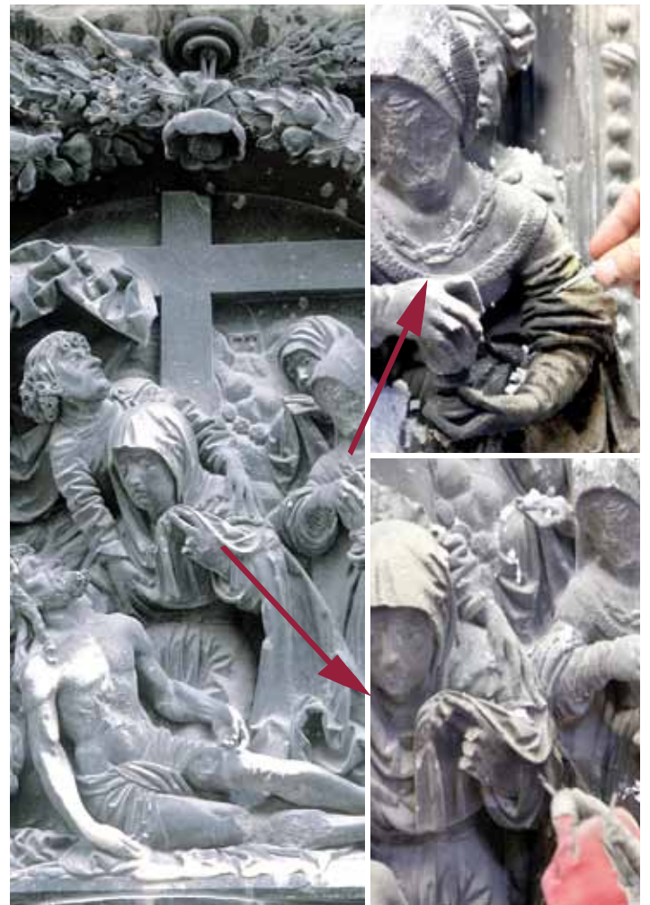
Mit dem Skalpell wird die angeweichte schwarze Kruste vorsichtig entfernt
