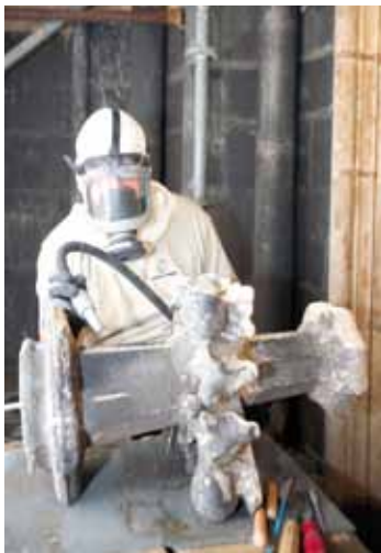
Reinigung der Oberfläche einer Kreuzblume mit dem Mikro-sandstrahlgerät
