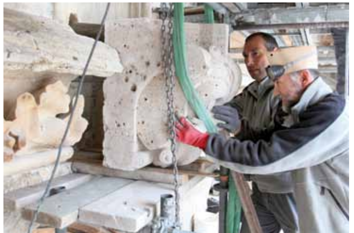
Versetzen der neuangefertigten Kopie des Maskarons
