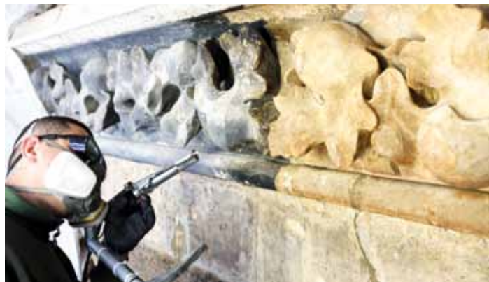
Laserreinigung des Blattwerkes am Südturm
