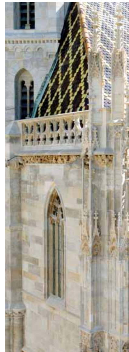
Linker Teil: bereits fertig restaurierte West- Rechter Teil: noch zu restaurierende Außenseite
