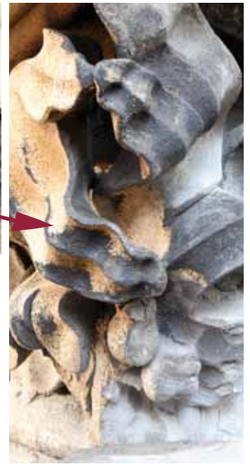
Fein ausgearbeitete Steinoberfläche
