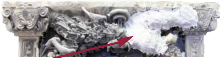
Mit feuchten Kompressen werden die Krusten angeweicht
