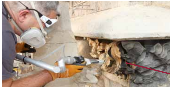
Laserreinigung des Blattwerkes oberhalb der Bartholomäuskapelle
