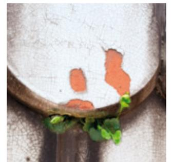
Schäden an einem Dachziegel – Sprünge und Abplatzungen der Glasur, Moose in den Fugen.
