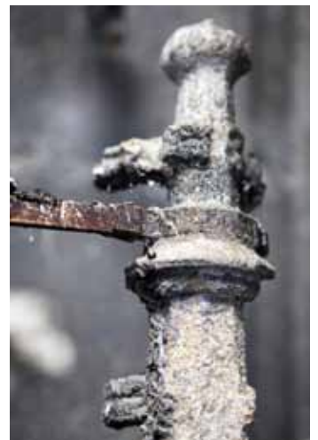
Eine kleine Fiale – unter deren schwarzer Kruste die Sandsteinoberfläche sehr stark verwittert ist.
