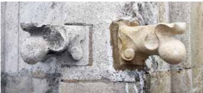
Links eine gereinigte, alte Krabbe, rechts eine neu angefertigte. Die Fugen wurden mit Restauriermörtel geschlossen.
