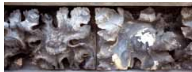
Das fein ausgearbeitete Blattfries ist eine besonders arbeitsaufwendige Aufgabe für die Steinrestauratoren.
