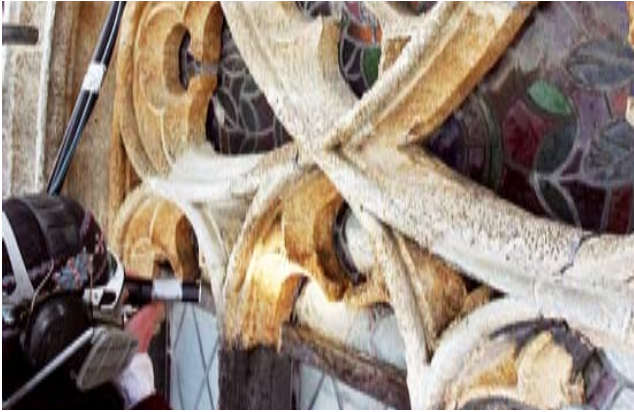
Die Laserreinigung des gotischen Fensters an der Westfassade.
