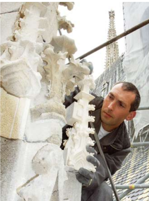
Die Anpassung eines in der Dombauhütte neu angefertigten Details einer Fiale (Nordwestecke der Westfassade).
