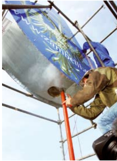
Aufsetzen auf die Verankerung
