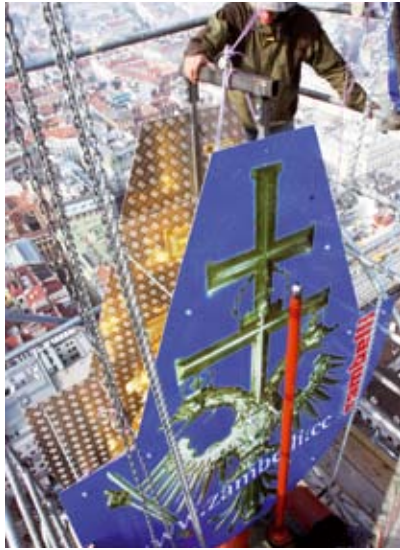
Spezialisten im Kampf gegen den Wind Anheben durch die 2 Flaschenzüge
