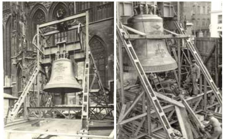
Das Stahlgerüst der Pummerin und die Montage des neuen Klöppels
