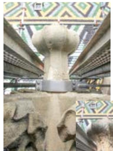
*Eine durchgerostete Eisenklammer wurde gegen eine neue aus Nirosta ausgetauscht*
