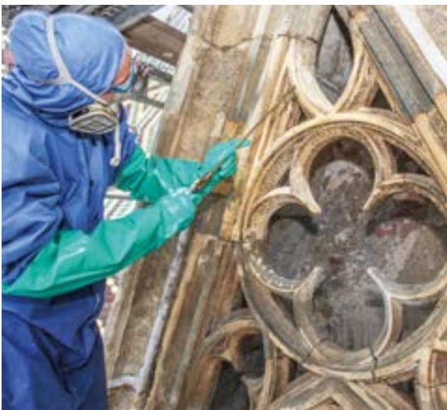
*Vorreinigung des Giebelmaßwerkes mit dem Mikrosandstrahlgerät*
