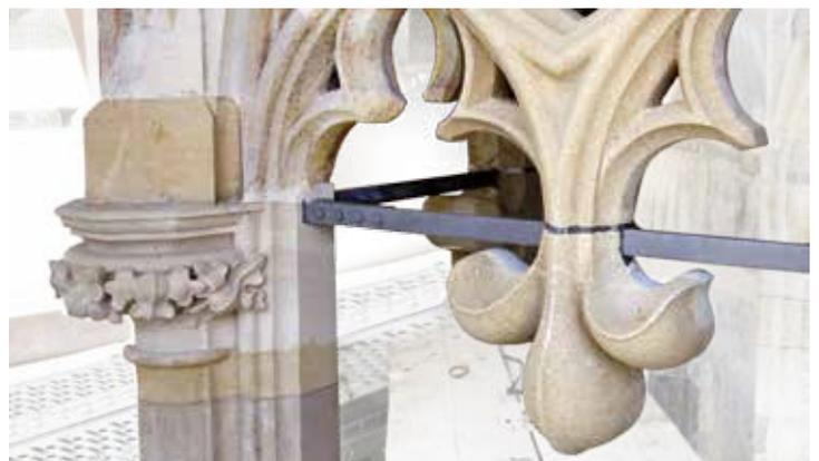
Die Spannungen zwischen Stein und Eisen, die sich bei Belastung und Temperaturänderung unterschiedlich verhalten, müssen bei der Kombination der beiden Materialien durch elastische oder weiche Verbindungen ausgeglichen werden. Ob die bald nach der Restaurierung der Turmspitze durch Sprenger aufgetretenen Schäden nur auf diesen konstruktiven Mangel oder auf andere Gründe zurückzuführen sind, können wir heute – da diese Konstruktion 1860 entfernt wurde – nicht mehr feststellen.
